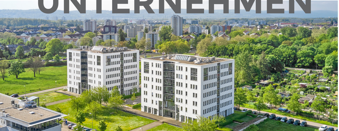
Head office Karlsruhe / Zentrale Karlsruhe
